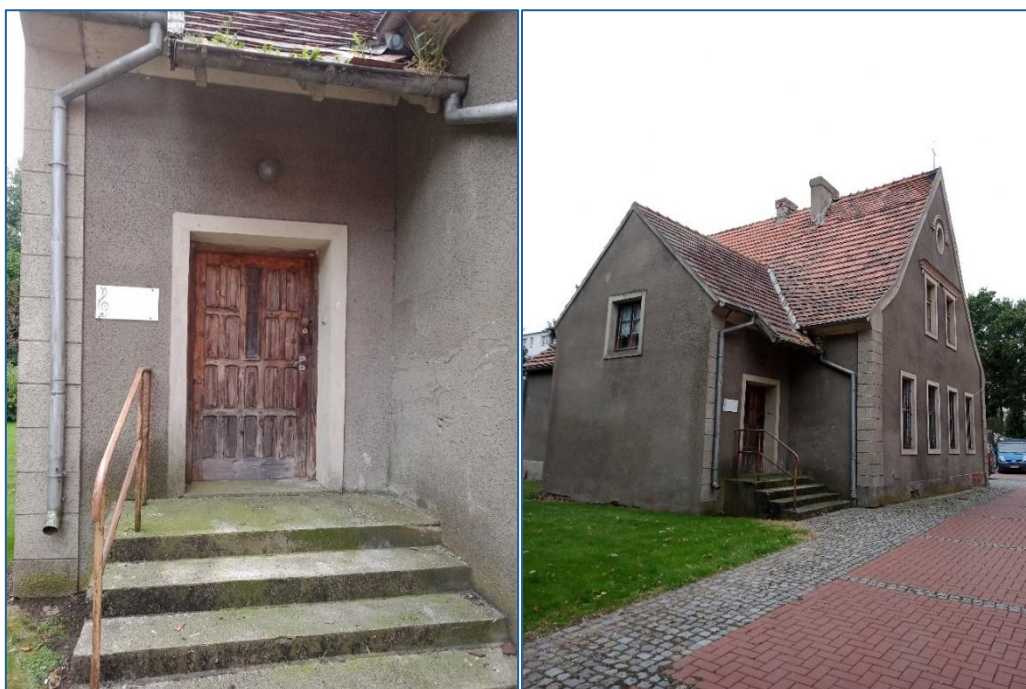
Ryc. 22 Budynek parafialny przy ul. Michała Drzymały 3
