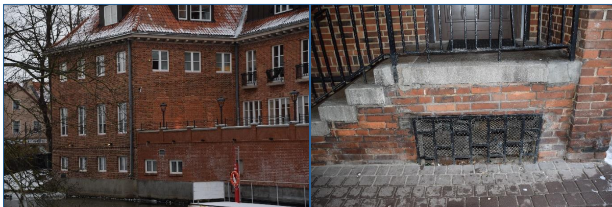
Ryc. 24 Budynek Starostwa Powiatowego w Nowym Dworze Gdańskim Źródło: materiały z wizji lokalnej przeprowadzonej w dniu 2.10.2023 r.
